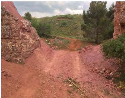
16. Il mio corpo vi seppellirà - fase di preparazione (lavori sentiero per accesso carrozze) - Cave di Bauxite - Spinazzola (Puglia)
